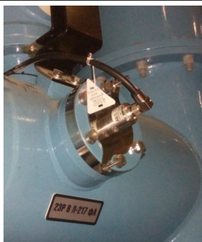
Рис. 2.5.3.2. Датчик AES/W на смотровом окне
