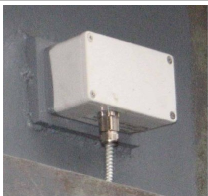
Рис. 2.6.1.2. Акустический датчик частичных разрядов марки AC-Sensor в монтажном корпусе
