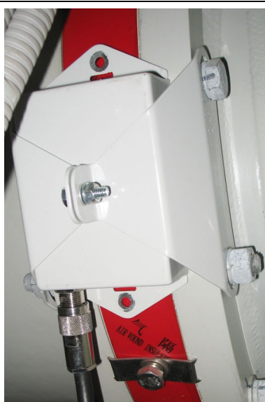
Рис. 2.5.1.2. Датчик марки AES, смонтированный на стыке корпусов (объемов) КРУЭ.
